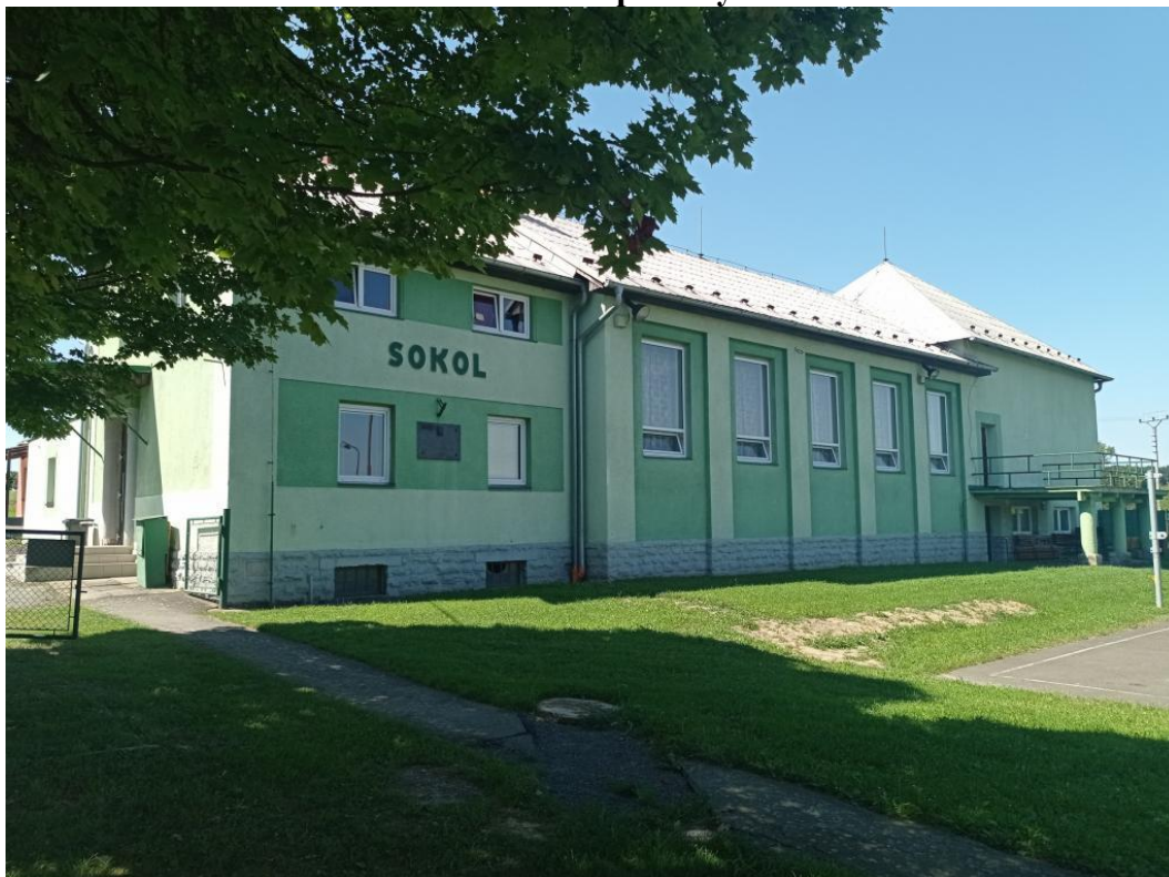
Místní sokolovna s přilehlými hřišti
